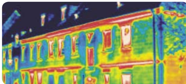
Infrarotaufnahme eines Mehrfamilienhauses mit schlechter Wärmedämmung
