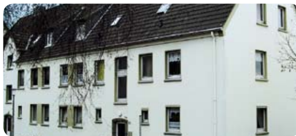
Realbild eines Mehrfamilienhauses mit schlechter Wärmedämmung
