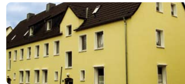
Realbild eines Mehrfamilienhauses mit guter Wärmedämmung
